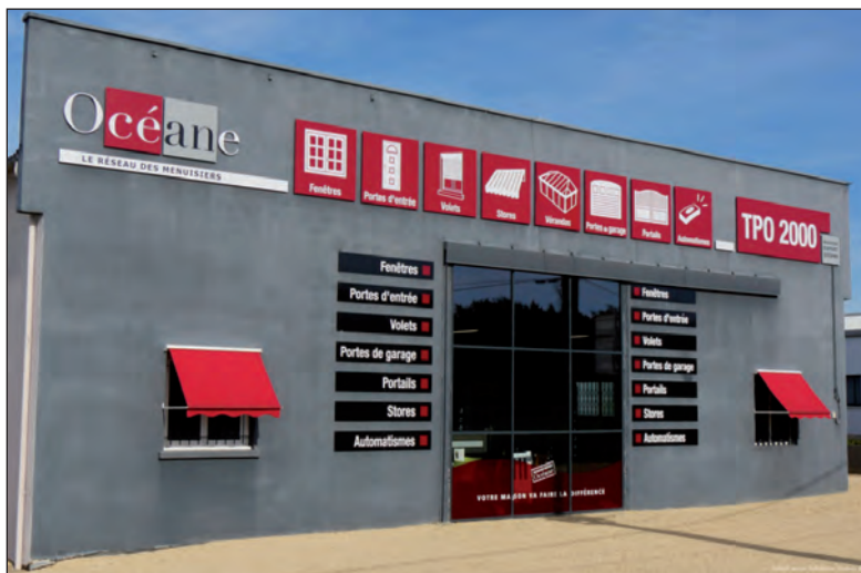
La façade de TPO 2000
