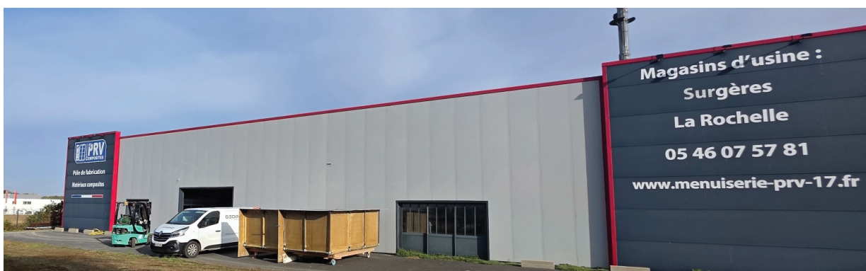
Façade du bâtiment de production composites à Forges
